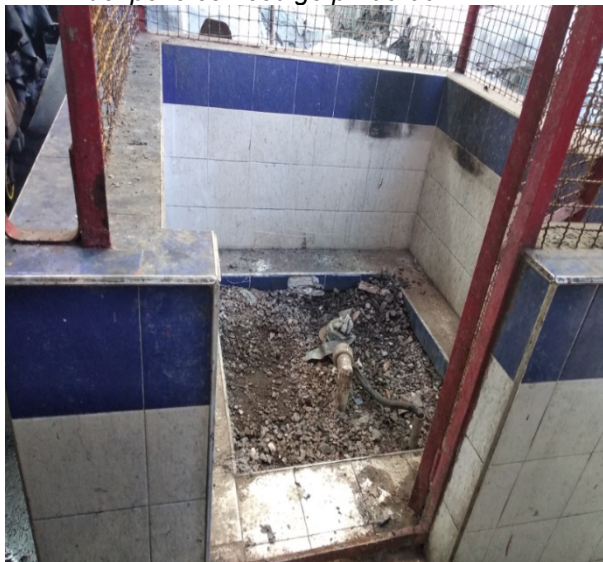
Fotografía 4. Estado actual del pozo.
